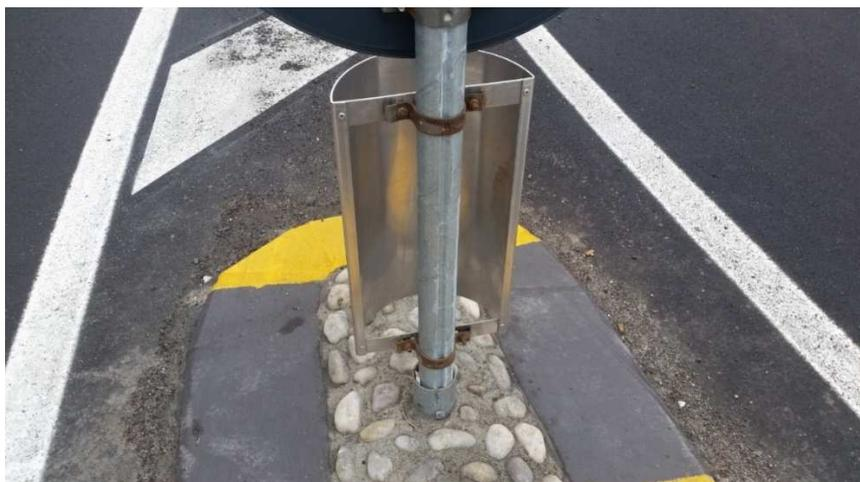
**Figura 2 – Esempio di segnaletica verticale rimovibile. La presenza del bicchiere annesso nel massetto permette la rimozione del palo in caso di transito di veicoli eccezionali.**
