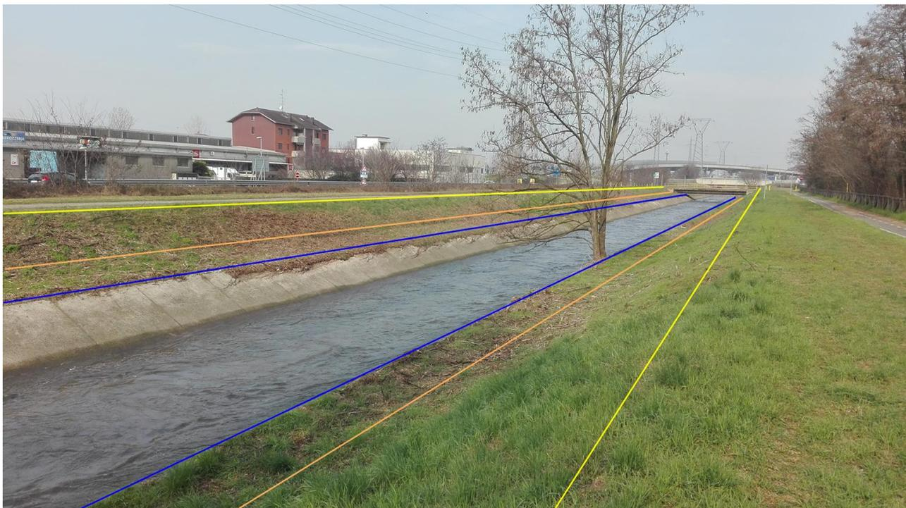
Figura 11. Tratto tipo del Canale Scolmatore Nord Ovest, con modesto rilevato arginale in froldo.
