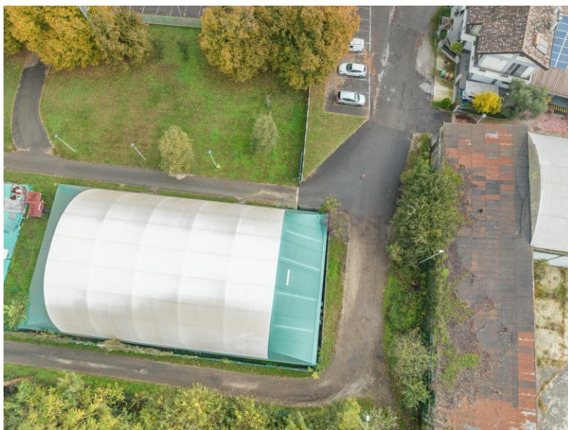
Ripresa fotografica da drone di Lombardini22 – a destra il campo sportivo e a sinistra il fabbricato in demolizione
