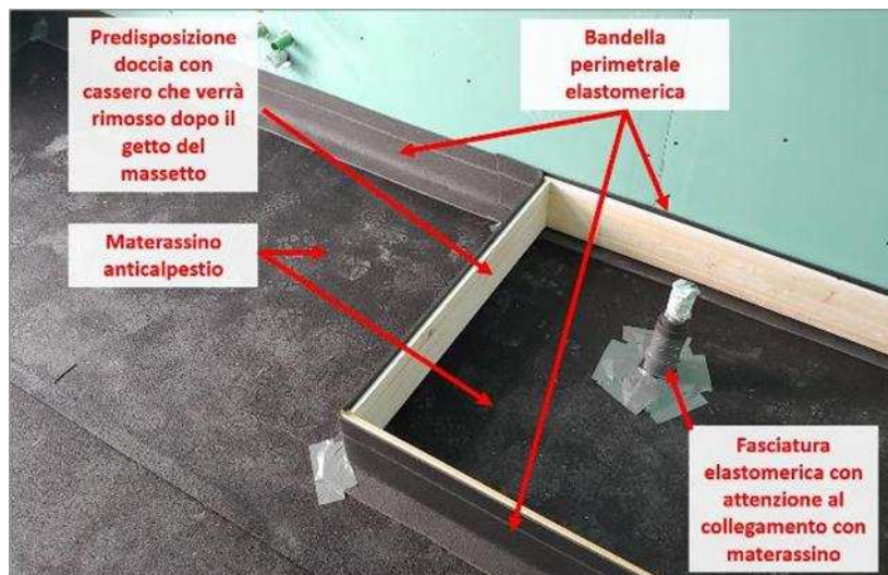
Altro esempio di preparazione per la posa di piatto doccia
