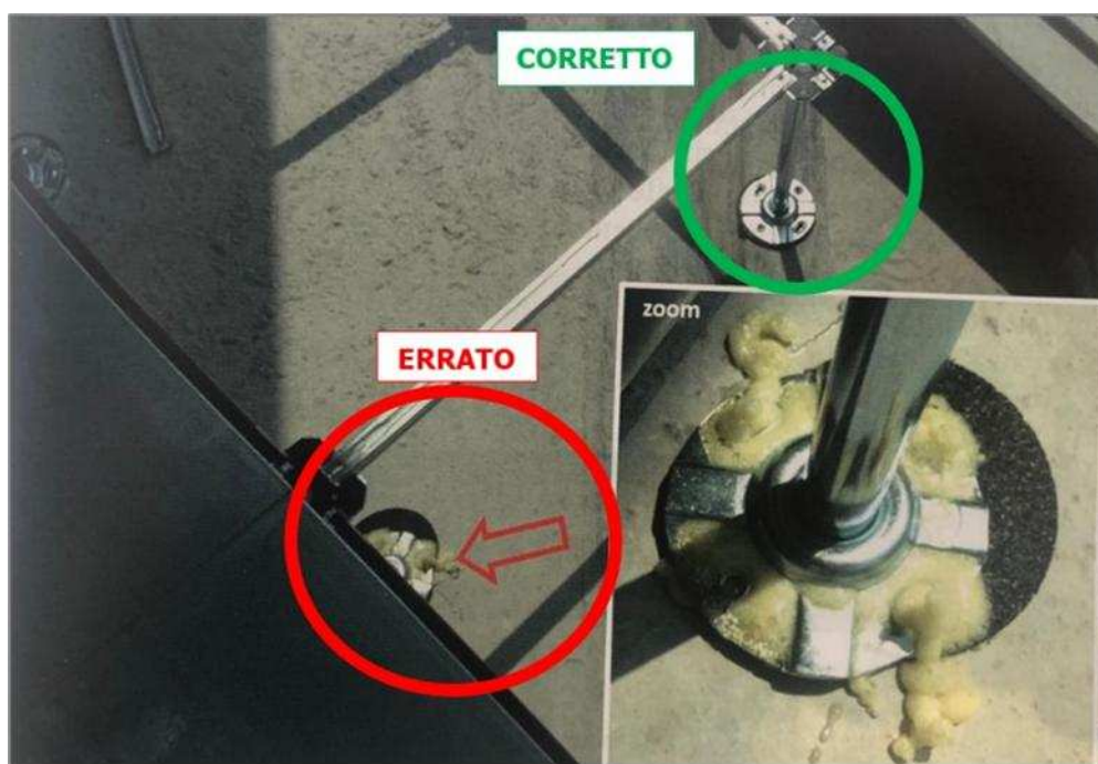
Esempi di posa dell'elemento desolarizzante sotto piedino
