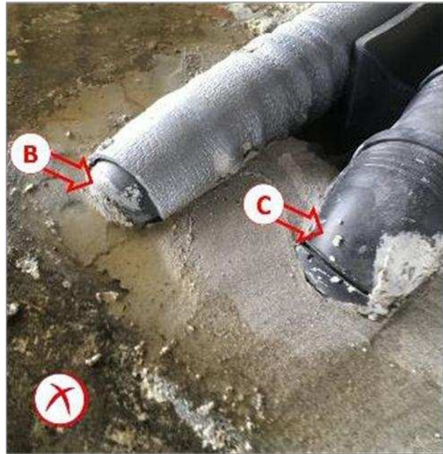
Esempio di errata disconnessione vibratoria delle tubazioni
