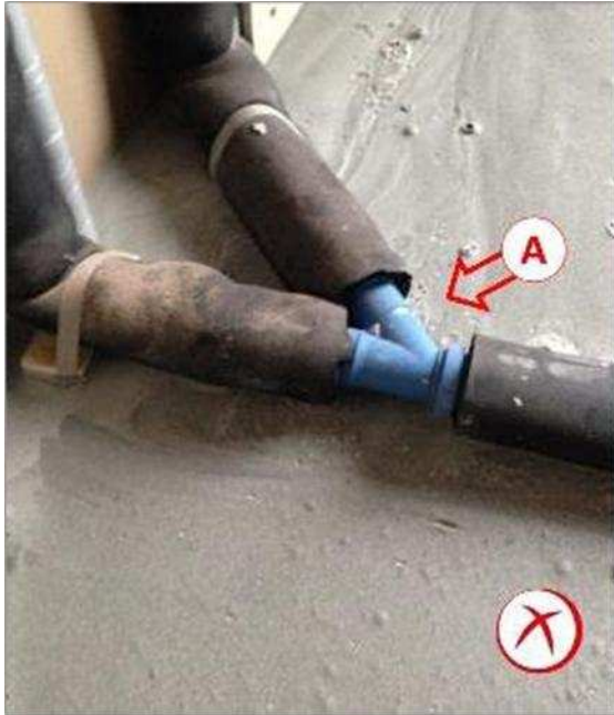
Esempio di errata disconnessione vibratoria delle tubazioni
