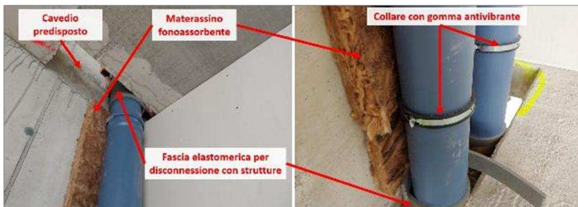
Posa di materassino fonoassorbente e di fascia elastomerica per disconnessione rispetto a strutture
