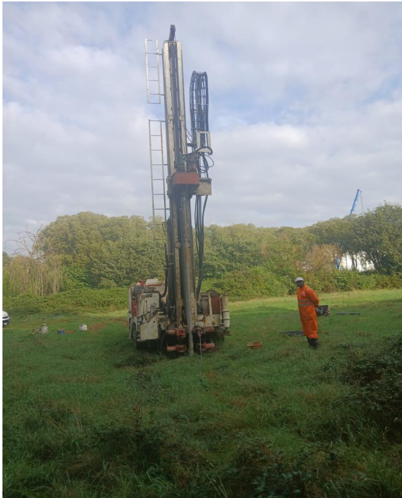
Figura 3 – Ubicazione Sondaggio S3
