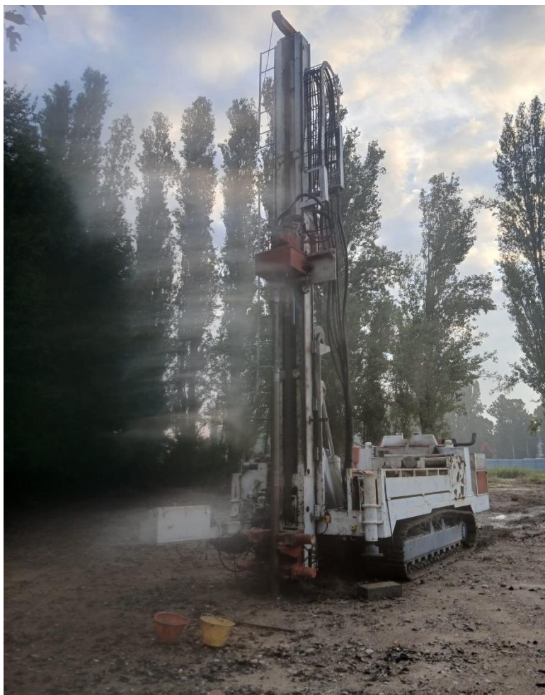
Figura 5 - Ubicazione Sondaggio S4
