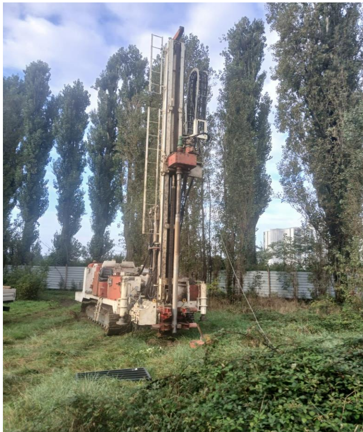
Figura 1 - Ubicazione Sondaggio S1
