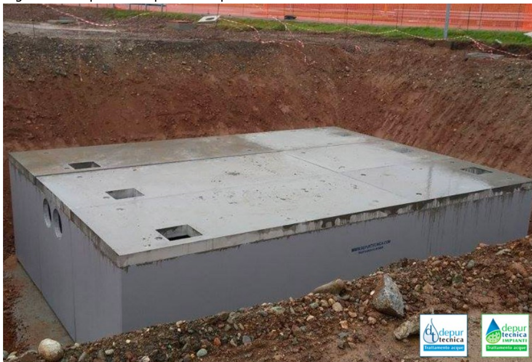
Figura 11 Esempio di vasca di laminazione in cls prefabbricato
