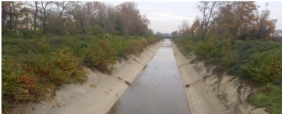
Figura 2-3 | La percezione del Canale Scolmatore Piene Nord Ovest al di fuori del perimetro dell'area ex Alemagna.
